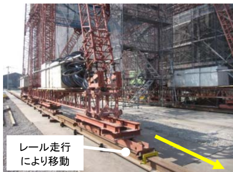
移動式折板屋根成型機構台の 施工例 (171002 深田鉄工有限会社 ホームページより)
