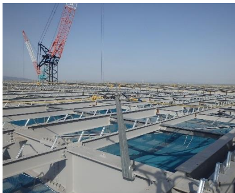
建方完了状況
