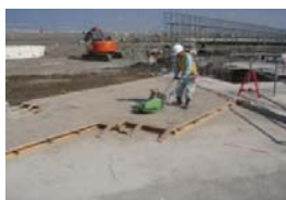
□砂型枠 施工例
