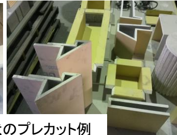
ボードプレカット材搬入状況
