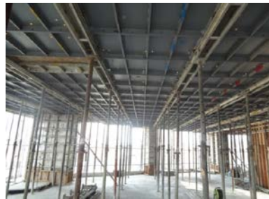
施工状況イメージ (例-2)
