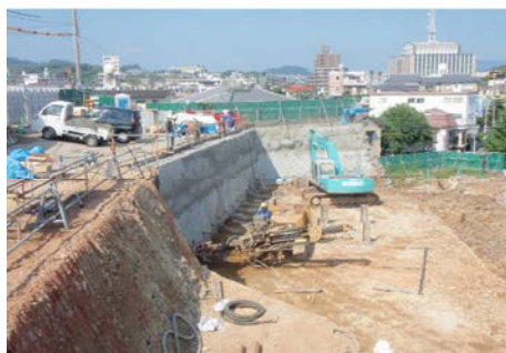
削孔・締め付け
