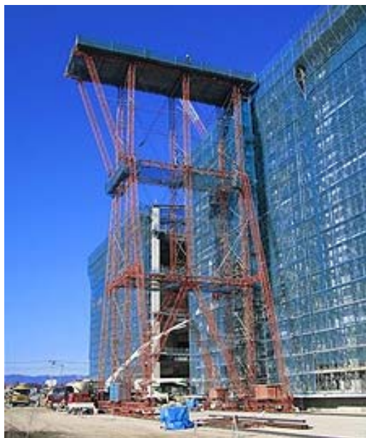
移動式折板屋根成型機構台の 施工例 (171002 深田鉄工有限会社 ホームページより)
