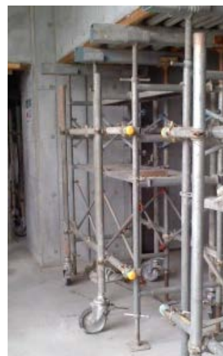
梁下型枠一体支保工(横移動型)
