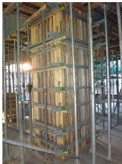
合板型枠使用例
