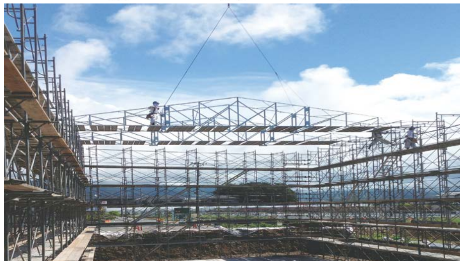
簡易屋根トラスの取り付け状況
