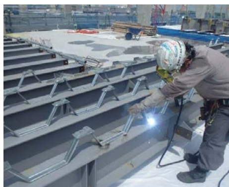
溶接作業状況
