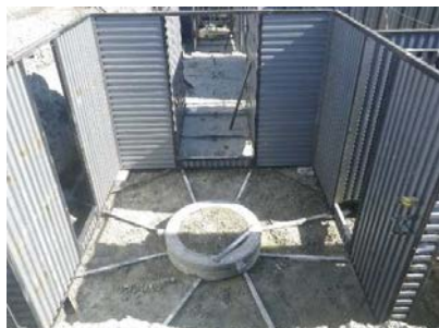
RADIX型枠建込状況
