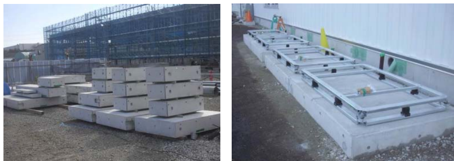
外構設備基礎のサイトPCa化事例
