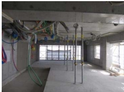
N-1階 室内状況
