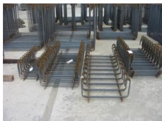
段差梁スターラップ筋
