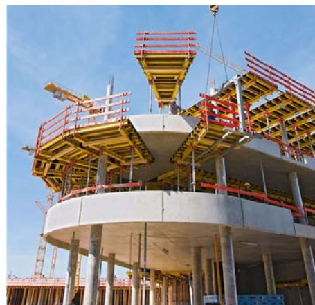
左: ペリー・ジャパン株式会社HPより (2018.01.11) 海外でのフラットスラブ構造での適用例
