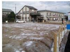
施工直後の状態
