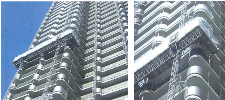
外壁改修工事での使用例
