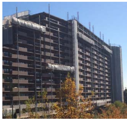
移動昇降式足場
