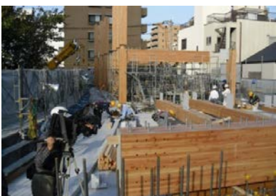
適用事例② 集成材(大断面)の建方工事状況
