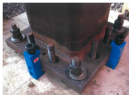
<柱脚の施工例(M48)>
