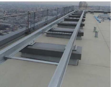
屋上機械基礎PCaの取付け後の状況
