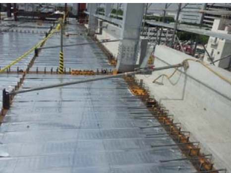
パラペットPCaの取付け後の状況
