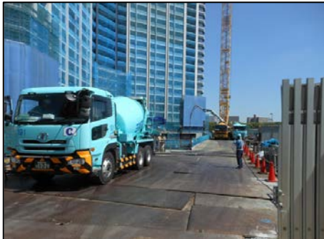
外構舗装基層を先行施工した上の鉄板敷きによる仮設道路
