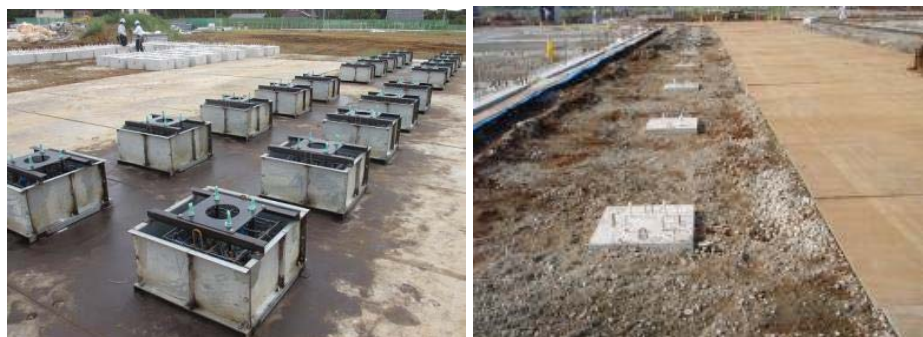
外廊下独立基礎のサイトPCa化事例
