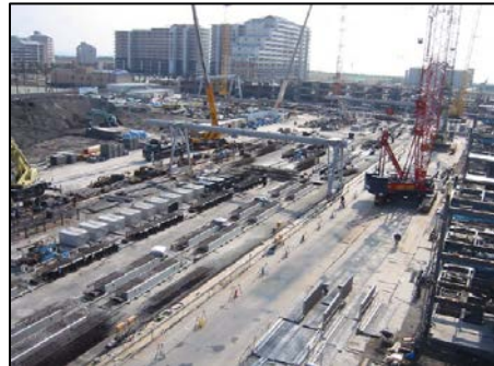
路盤砂利ままのサイトPCaヤードと鉄板敷きによる仮設動線
