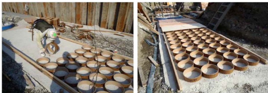
□ボイド型枠 施工例
