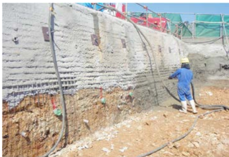
補強材設置 ワイヤーメッシュ・吹付け
