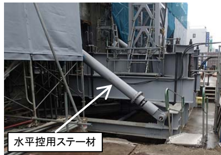
鉄骨架台設置状況②
