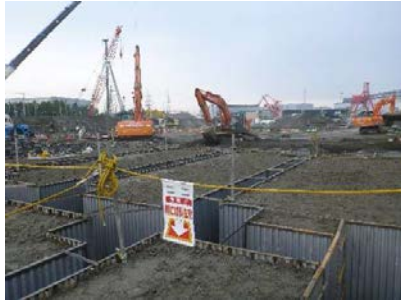
先行埋め戻し完了状況
