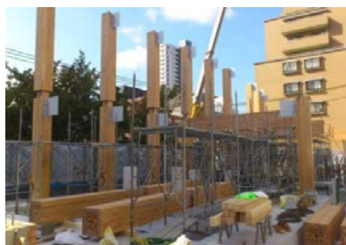
適用事例② 集成材(大断面)の建方工事状況
