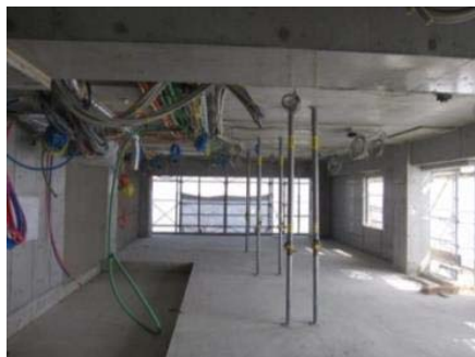
N-1階 室内状況
