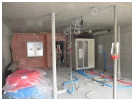
N-2階 室内状況
