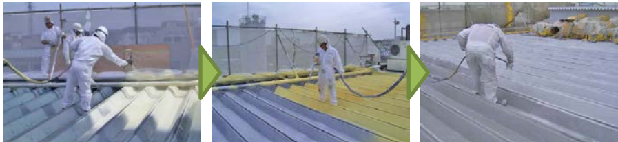
専用吹付け機で発泡材を均一に吹付ける
