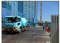
外構舗装基層を先行施工 した上の鉄板敷きによる 仮設道路
