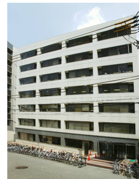
改修前の外観
