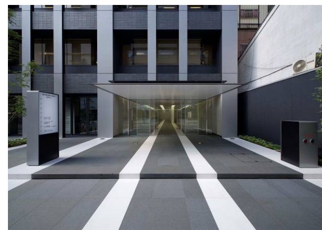
改修後のエントランス
