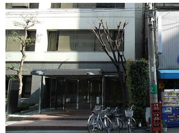
改修前のエントランス
