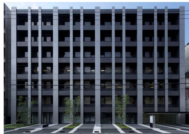
改修後の外観
