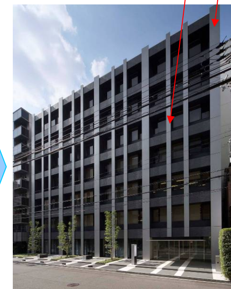
改修後の外観
