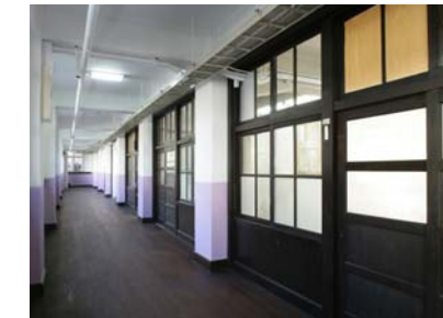
改修後 廊下写真
