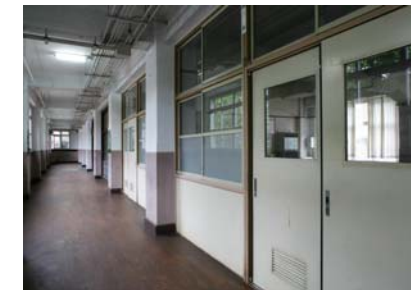
改修前 廊下写真
