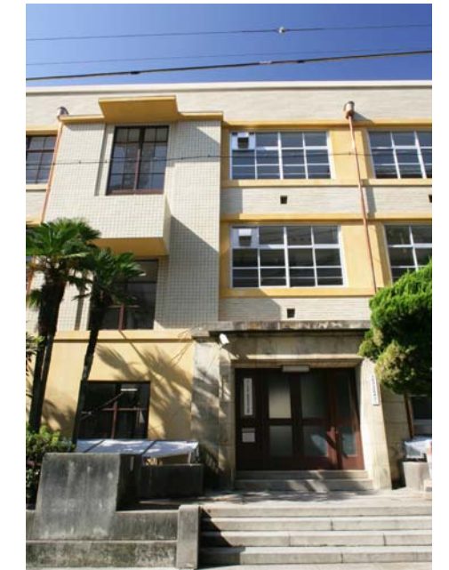
改修後 東側玄関部外観写真
