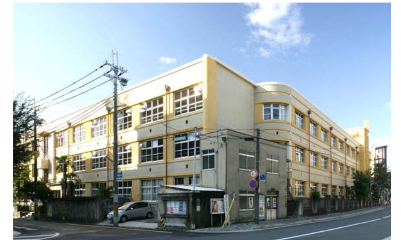
改修後 北東側外観写真
