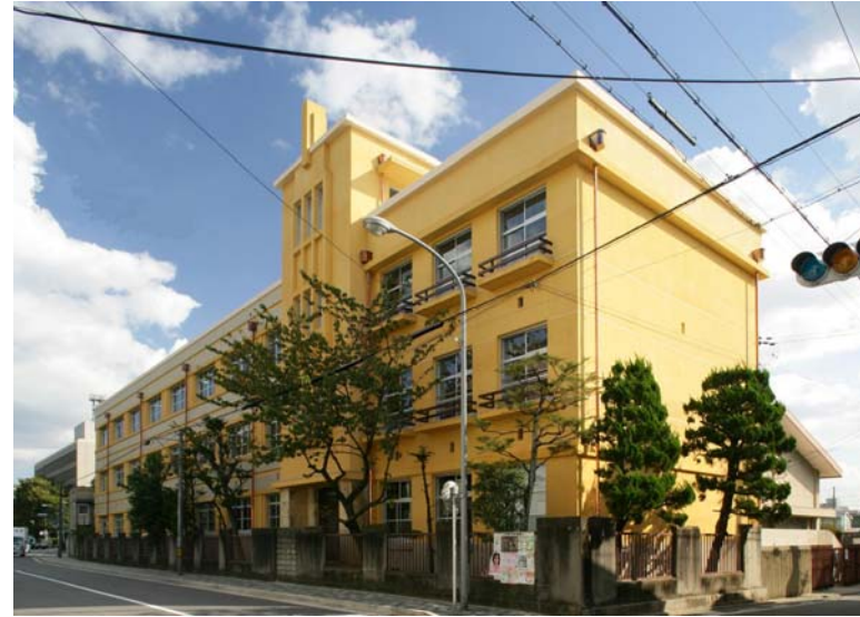
改修後 北西側外観写真
