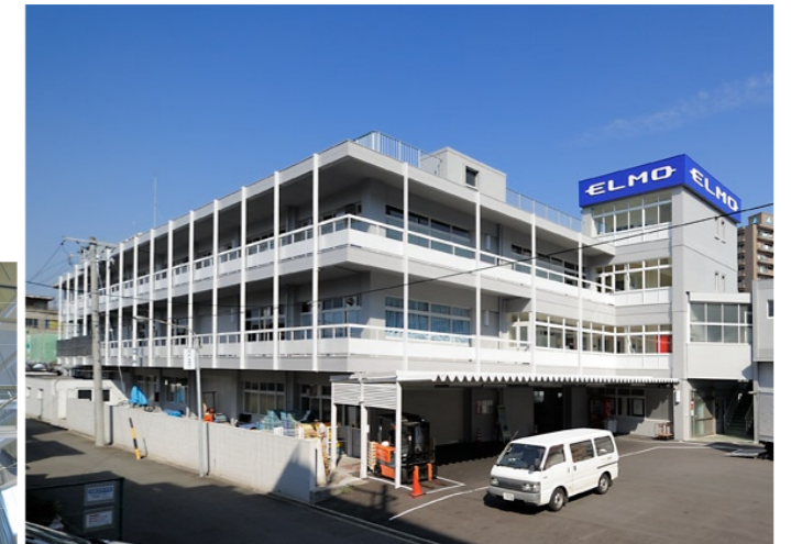
改修後の西工場
