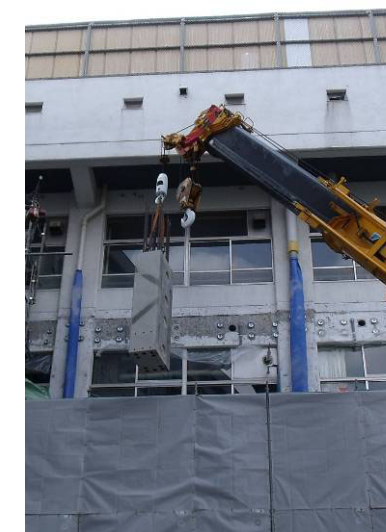
PCa柱吊り込み状況
