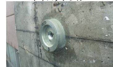
ディスクアンカー施工状況
