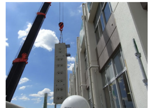
PCa柱吊り込み状況
