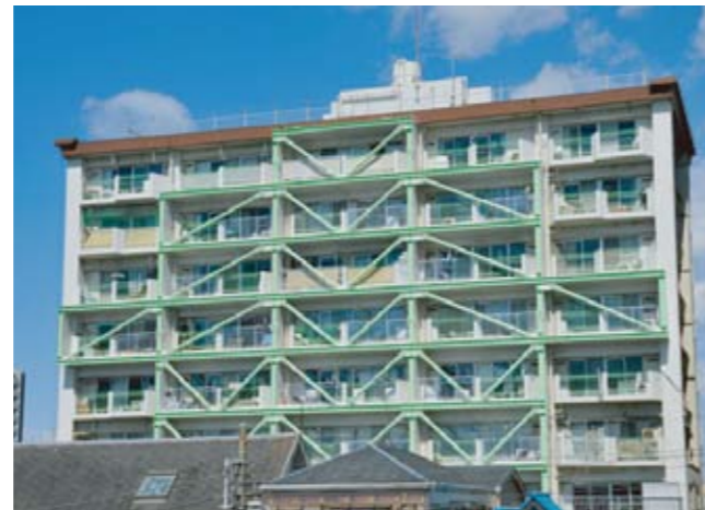
補強建物全景(南面)
