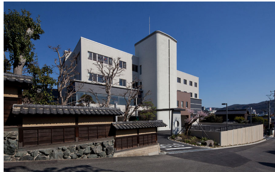
外観（前面道路から望む）
