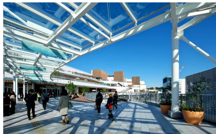
辻堂駅からテラスへ通じるアプローチ
