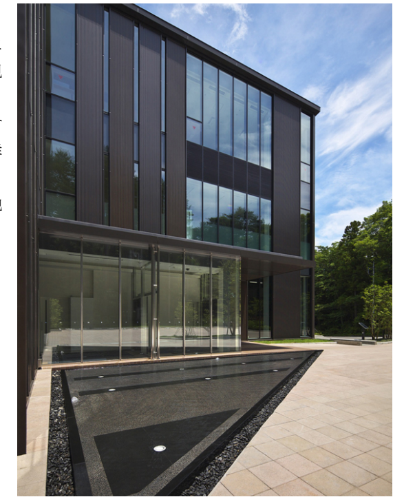
地下水を利用した水盤
