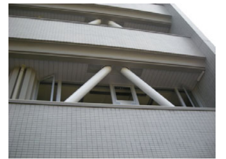
ブレース見上げ
