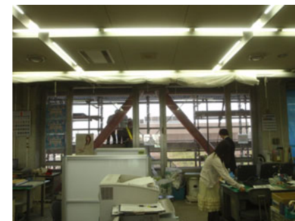
ブレース建込み完了
