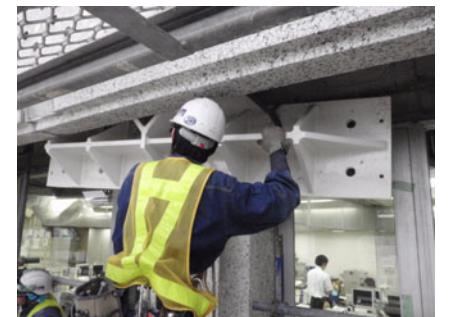
耐圧版の設置状況
