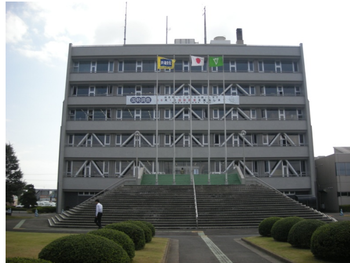
耐震補強後の岩沼市庁舎
