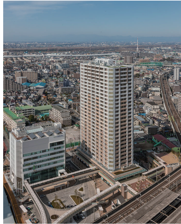
鳥瞰（中央が対象建物）
