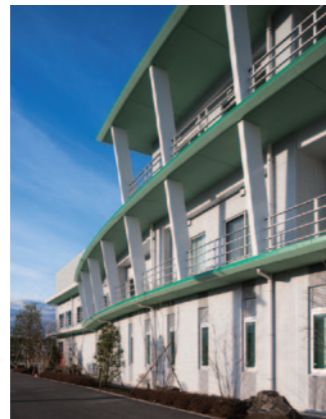
曲面迫出しバルコニー
