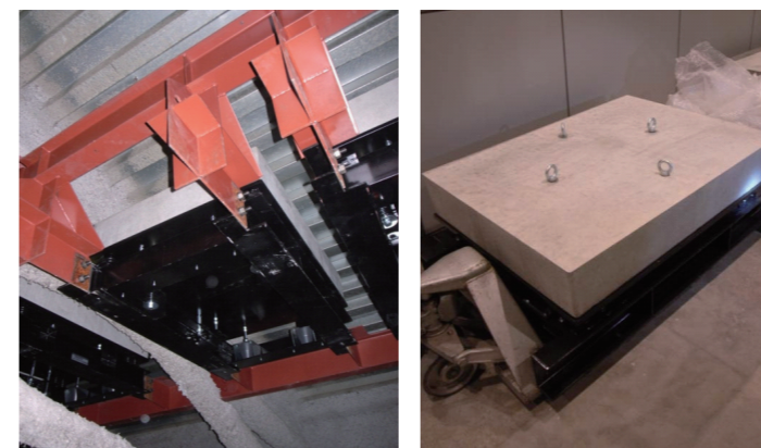
建物振動制御するTMD（制振装置）
