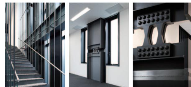
吹抜け内制震装置 事務室内制震装置 制震間柱・裏波溶接
