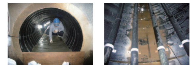
雨水配管への循環配管設置状況
