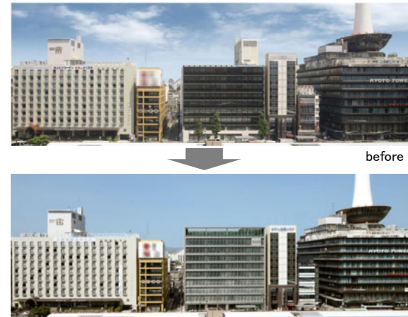
写真-1 改修前後の外観写真
