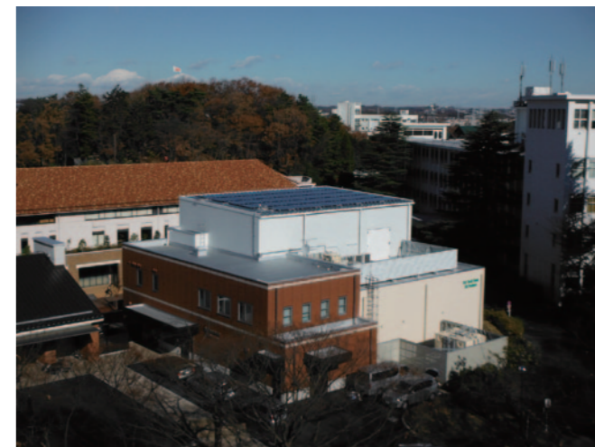
屋根面の太陽光発電
