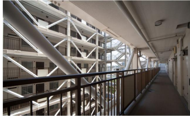
写真 制震ブレース取付状況(廊下内部より)
