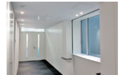
左手が事務所入口（上部自然換気口）、右手前エコヴォイド 共用廊下
