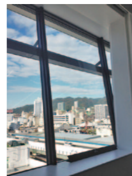
事務室窓廻り
