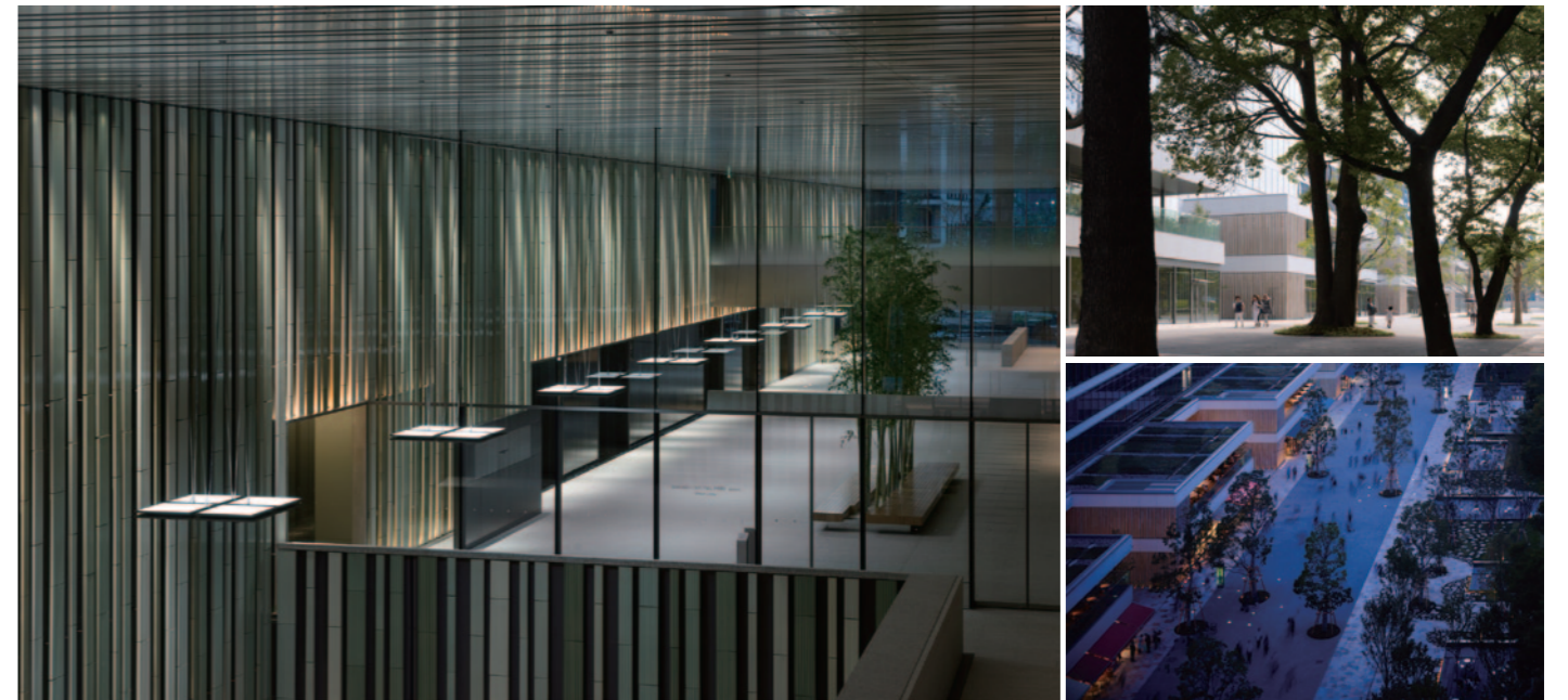
自然が内部化されたオフィスロビー 建築と公園が一体となった賑わい空間
