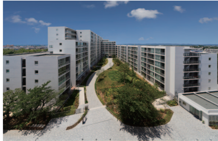
外観：中庭は地域に開放している
