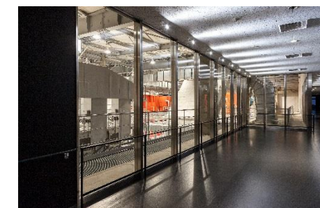
焼却炉室見学スペース
