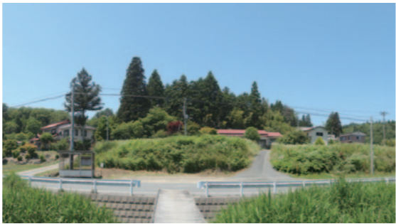
外観写真 (着工前)
