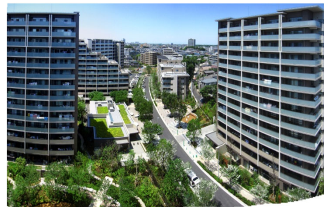
住棟とセンターコアの俯瞰
