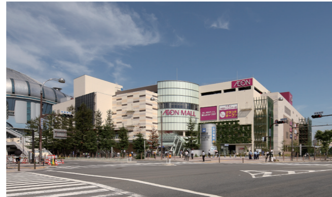
外観写真（南東から）
