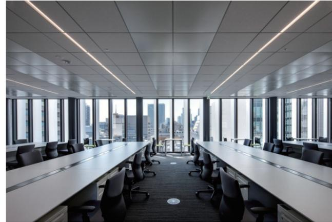
放射パネルとライン型LED照明による基準階事務室天井
