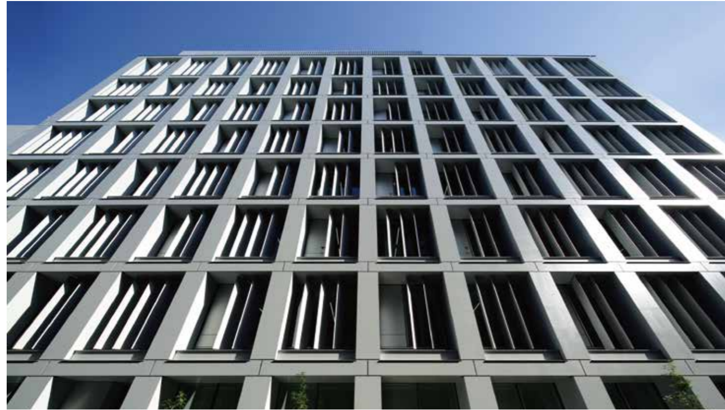
シミュレーションにより決定した角度のエコフィンが全面に取りつく外観
