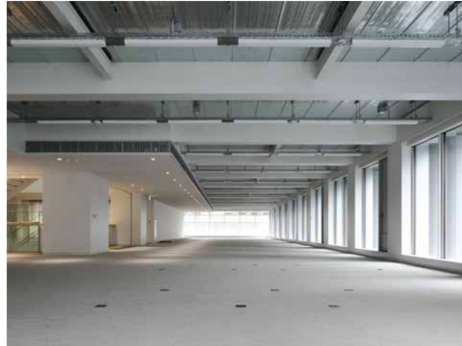
全面床吹出空調の採用で天井材を無くし、低階高でも解放的な事務室
