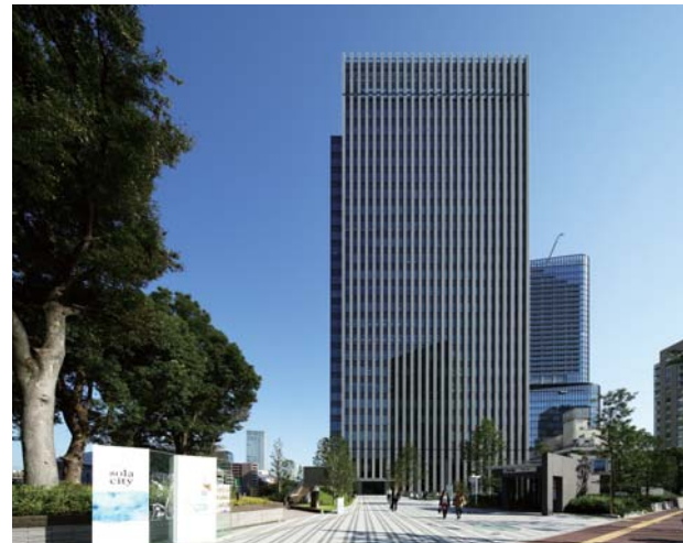
エントランスアプローチ
