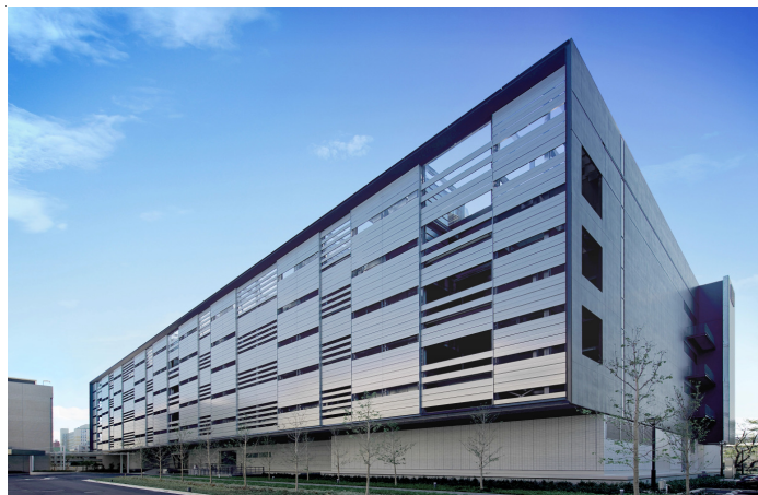
設備機能をそのまま形態化した、工業製品のような外観
