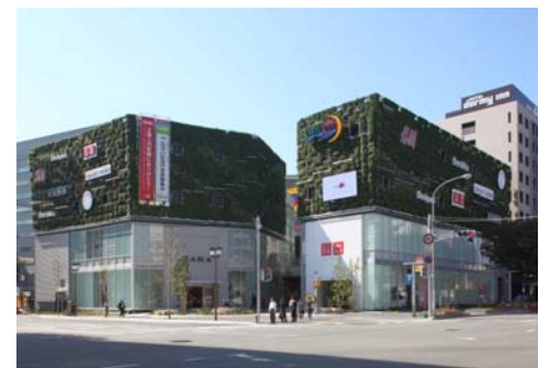
北側立面 (博多駅側)
