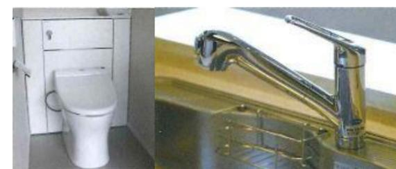
節水型便器・節湯型キッチン水栓の採用
