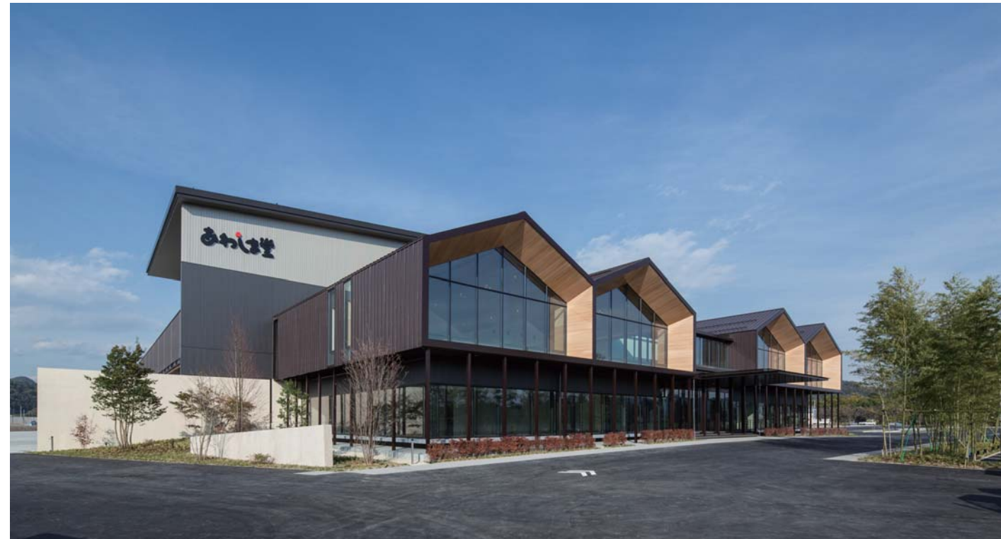
周囲の山々と呼応する切妻小屋組みの外観
