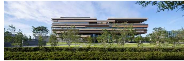
写真-1 北側正面外観
