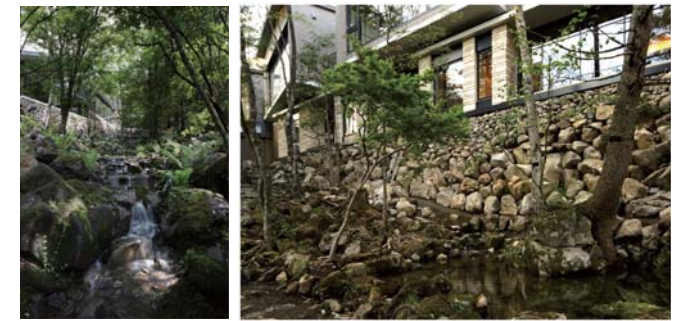
噴出水を利用した潭の流れ(左)と、現地の石を積み上げた建物基礎部(右)
