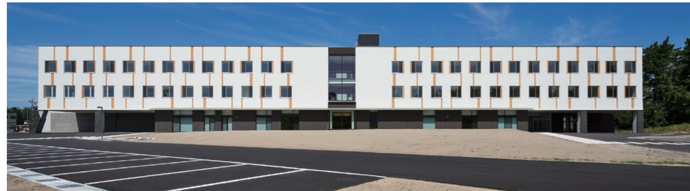
建物正面 敷地境界に門扉・フェスは存在しない
