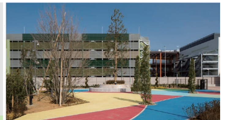
ららぽーと公園より北側立体駐車場を見る
