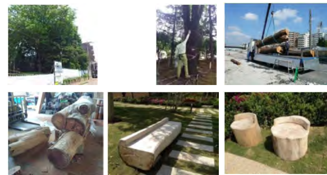
既存大ケヤキをベンチ・スツールに再利用 (既存～切断～搬出～乾燥・加工)
