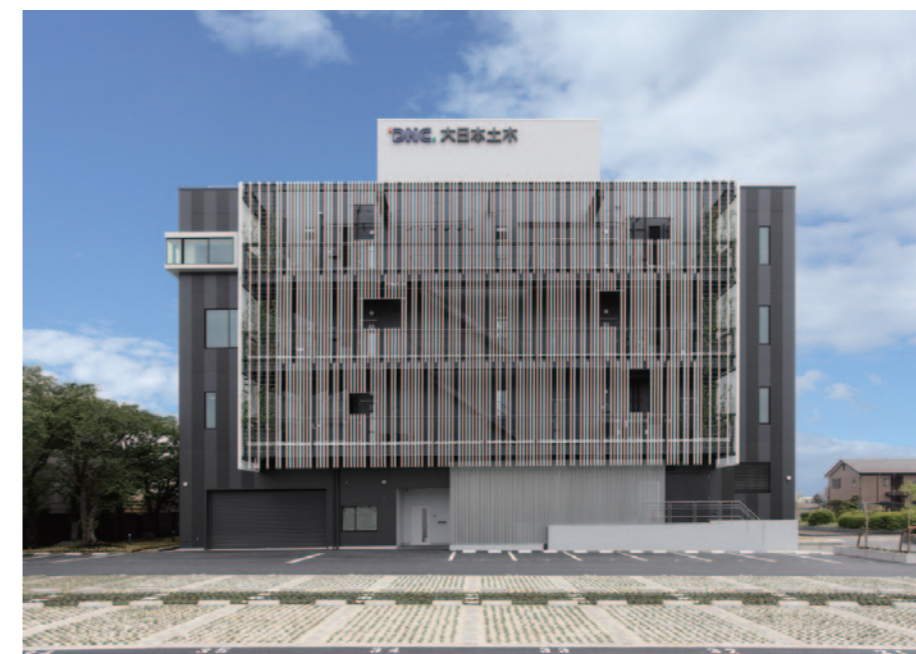
外観北面（ルーバーの両サイドに壁面緑化 手前はグリーンパーキング）
