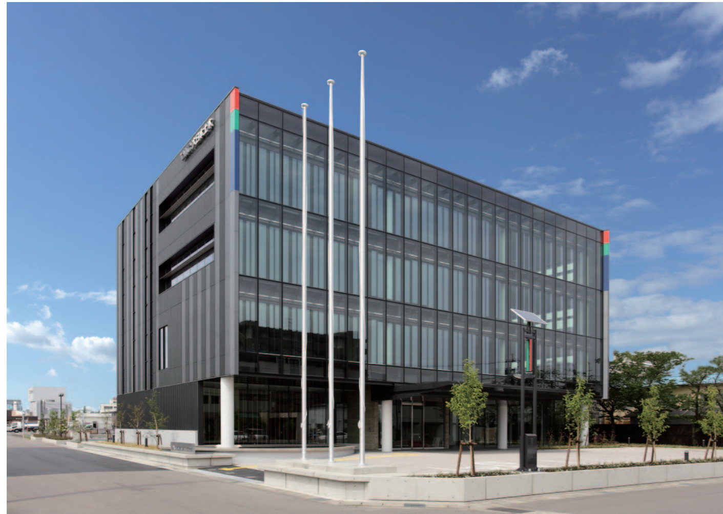
外観南西面（ダブルスキン内の日射追尾ブラインドが上がった状態。南側来客用駐車場にパーフェクトクールを採用）
