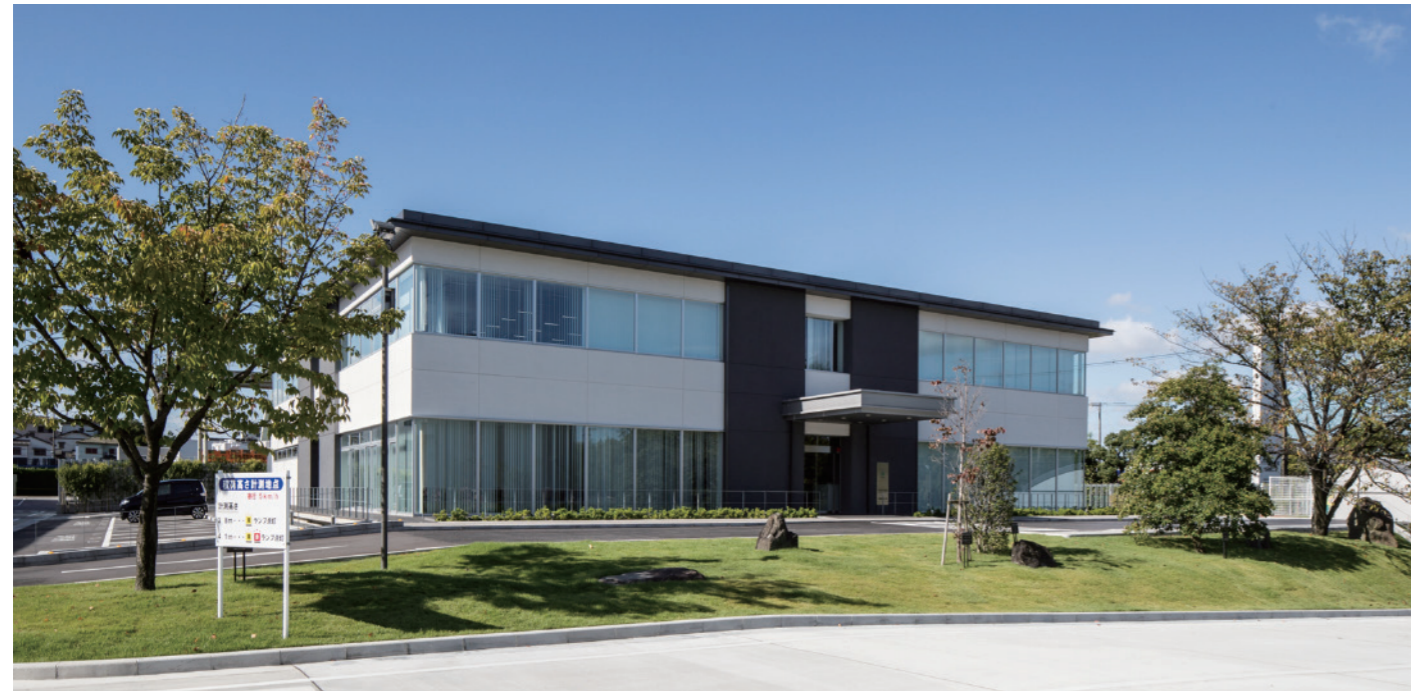
免震構造とRC-S造のハイブリット構造を採用。開放感のある執務空間を実現
