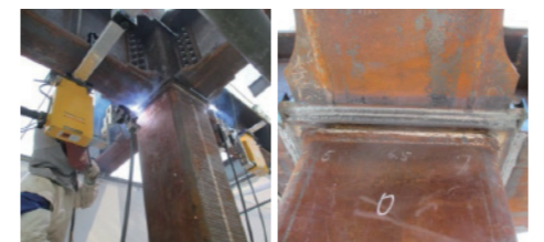
現場上向きロボット溶接
