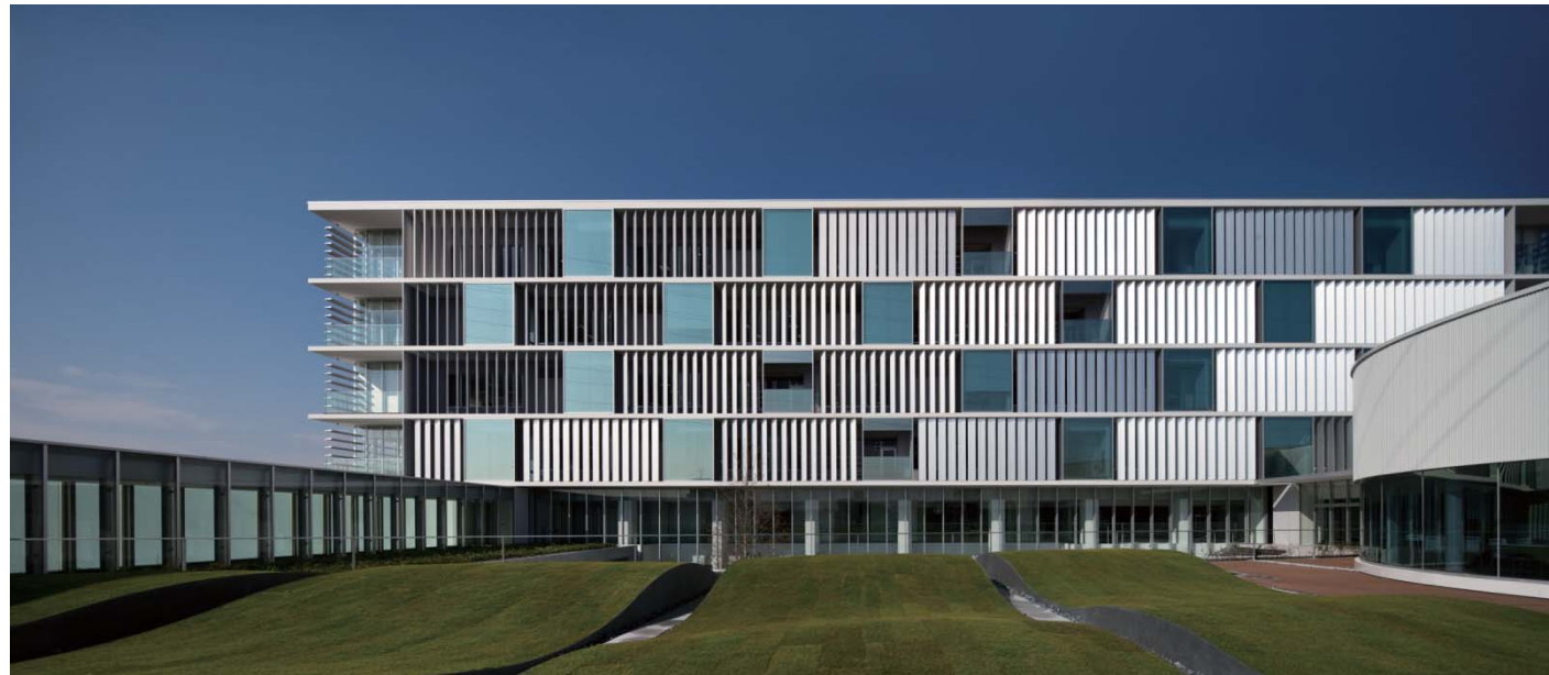
低層棟2階からルーフガーデンから見る高層棟
