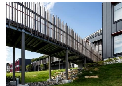
敷地から出た転石を利用した外構
