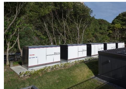
自立型水素エネルギー供給システム(東芝H 2 One)
