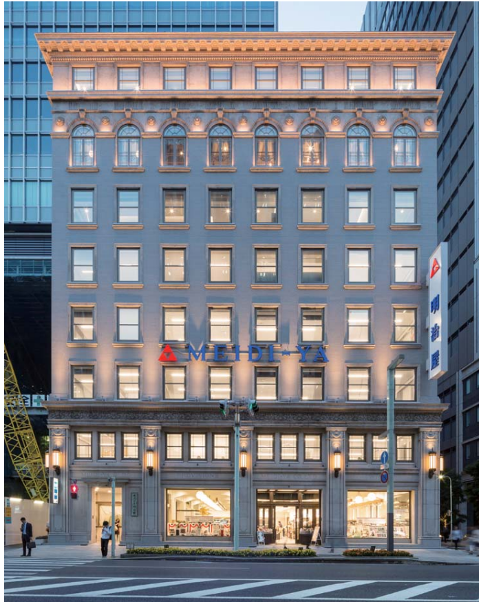
中央通り側の壁面ライトアップ撮影※1
