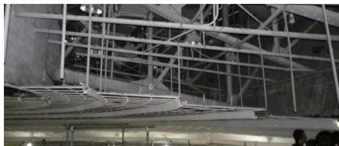
写真-2 既存天井の状況
