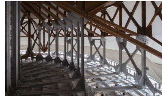
写真-3 改修後のぶどう棚直張り方式の天井下地
