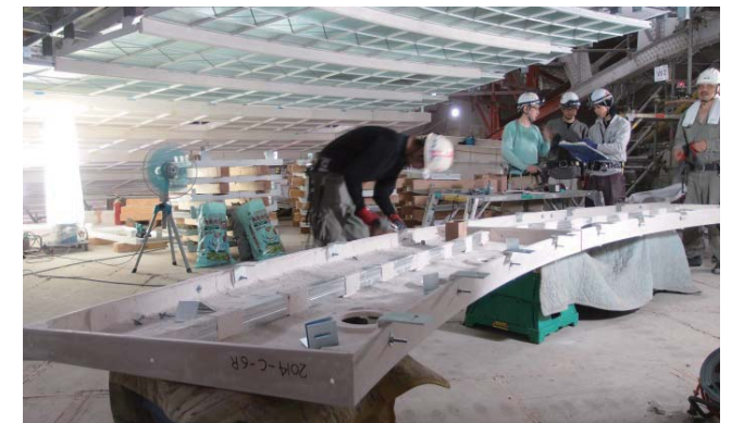
写真-4 GRGパネルによる天井材の軽量化
