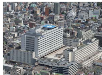
I 期工事完成時
