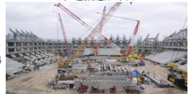
PC部材を大型クレーンで施工
