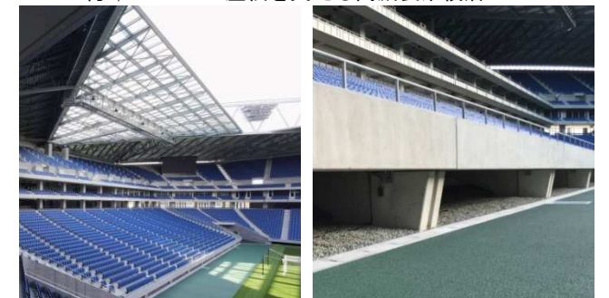
ガラス屋根と通風スリット
