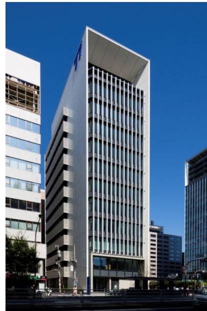
縦ルーバーによる日射制御：西側外観
